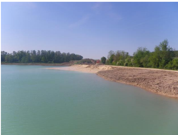
Berge Ouest en cours de réaménagement (ENCCEM)
