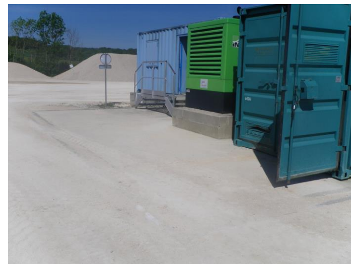
Aire étanche pour le stationnement, le ravitaillement et le lavage des engins (ENCEM)
