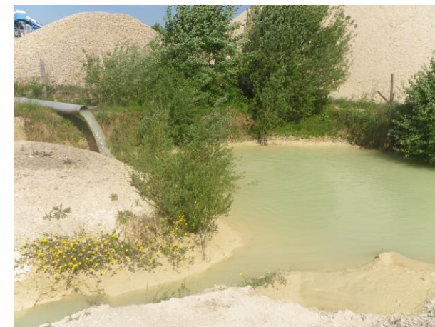
Point de rejet des eaux de procédé clarifiées dans le bassin de décantation / pompage / rejet (ENCEM)
